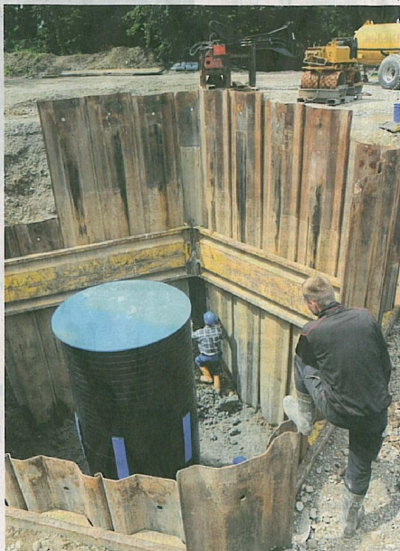
Der Apfeldorfer Trinkwasserbrunnen wird saniert.
