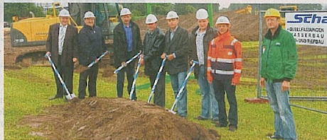
Beim symbolischen Spatenstich waren dabei (von links): zweiter Bürgermeister Hans Weigele, Pfaffenhausens Bürgermeister Roland Krieger, die drei Geschäftsführer der Firma Rampp Siegfried Merk, Hermann Rampp und Christian Weigele, Simon Scharp von der Firma Scharp (Dirlewang), sowie von der Bauunternehmung Glass Juniorchef Björn Glass und Bauleiter Franz Link.
