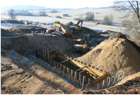
Quellgrubenverbau im Grundwasserbereich mit Wasserhaltung über Saughlanzen
